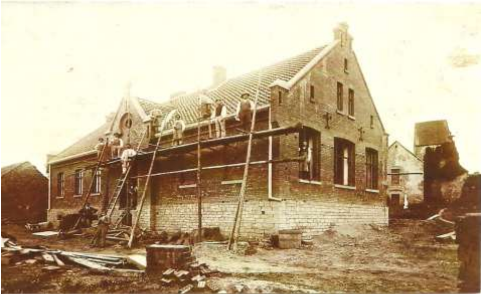
Der Schulbau kurz vor der Fertigstellung
